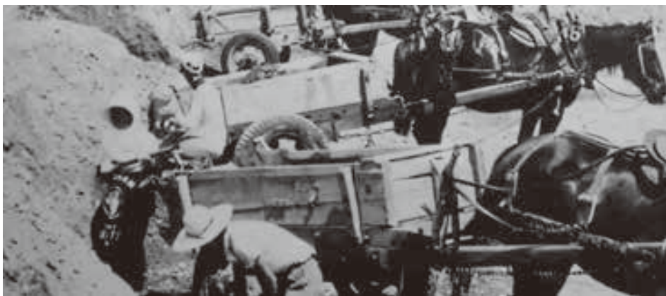
築堤工事の人力積込み、馬車運搬
