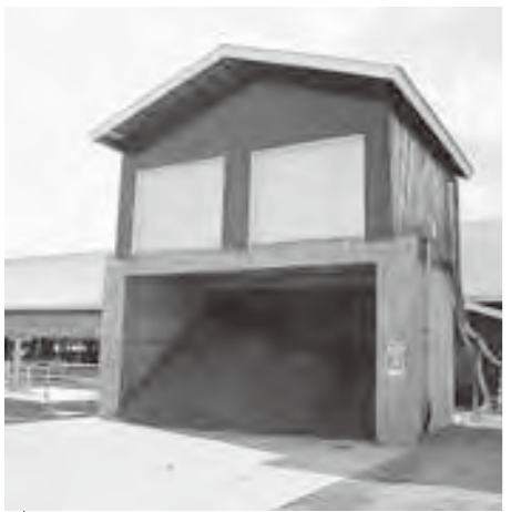
固液分離機を導入し、糞尿処理量の削減と堆肥発酵促進につなげます。
