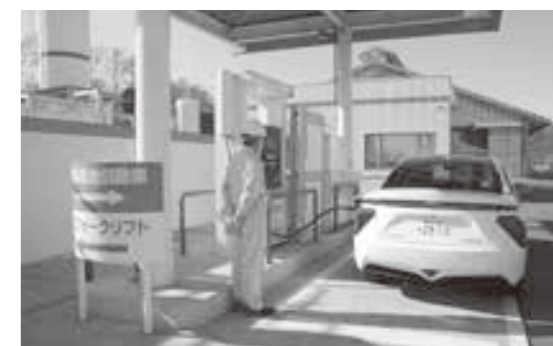
水素を充填している様子 「株しかおい水素ファーム」の水素ステーション (中鹿追)
